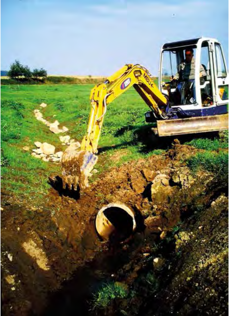
Renaturierung von Fließgewässern, Foto : Jeannette Gosteli
