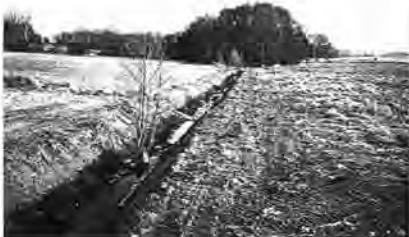
Kallbach nach dem Rückbau der Betonlemente
