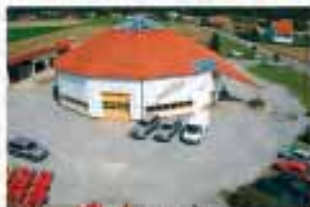
Lift-Manager Zentral Jänkendorf
