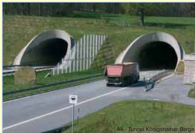
A4 - Tunnel Königshainer Berge
